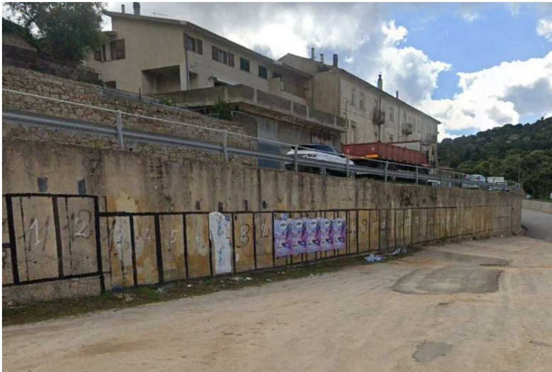
Vista sul muro di contenimento di via Stazione oggi totalmente degradato
