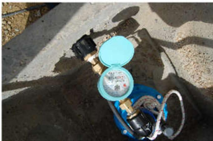
**Fig. 9/A:** particolare del sistema di monitoraggio installato nei pozzi in emungimento
