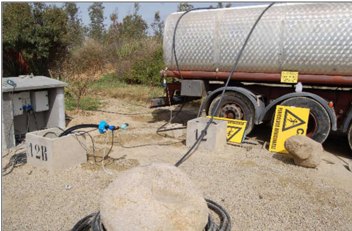
**Fig. 7/B:** cisterna per l'accumulo delle acque emunte. Sistema "Pump and stok"
