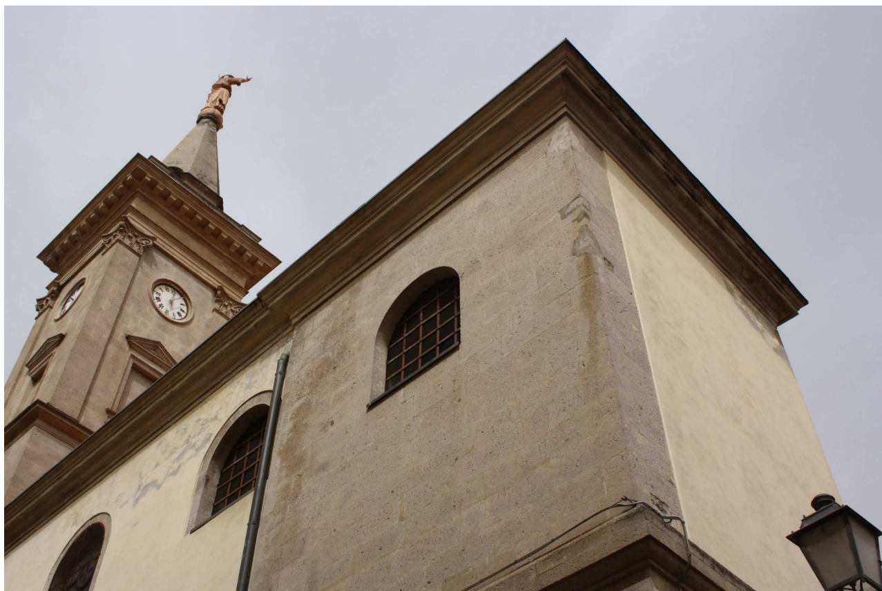
17 - Retrofacciata, cornicioni ammalorati
