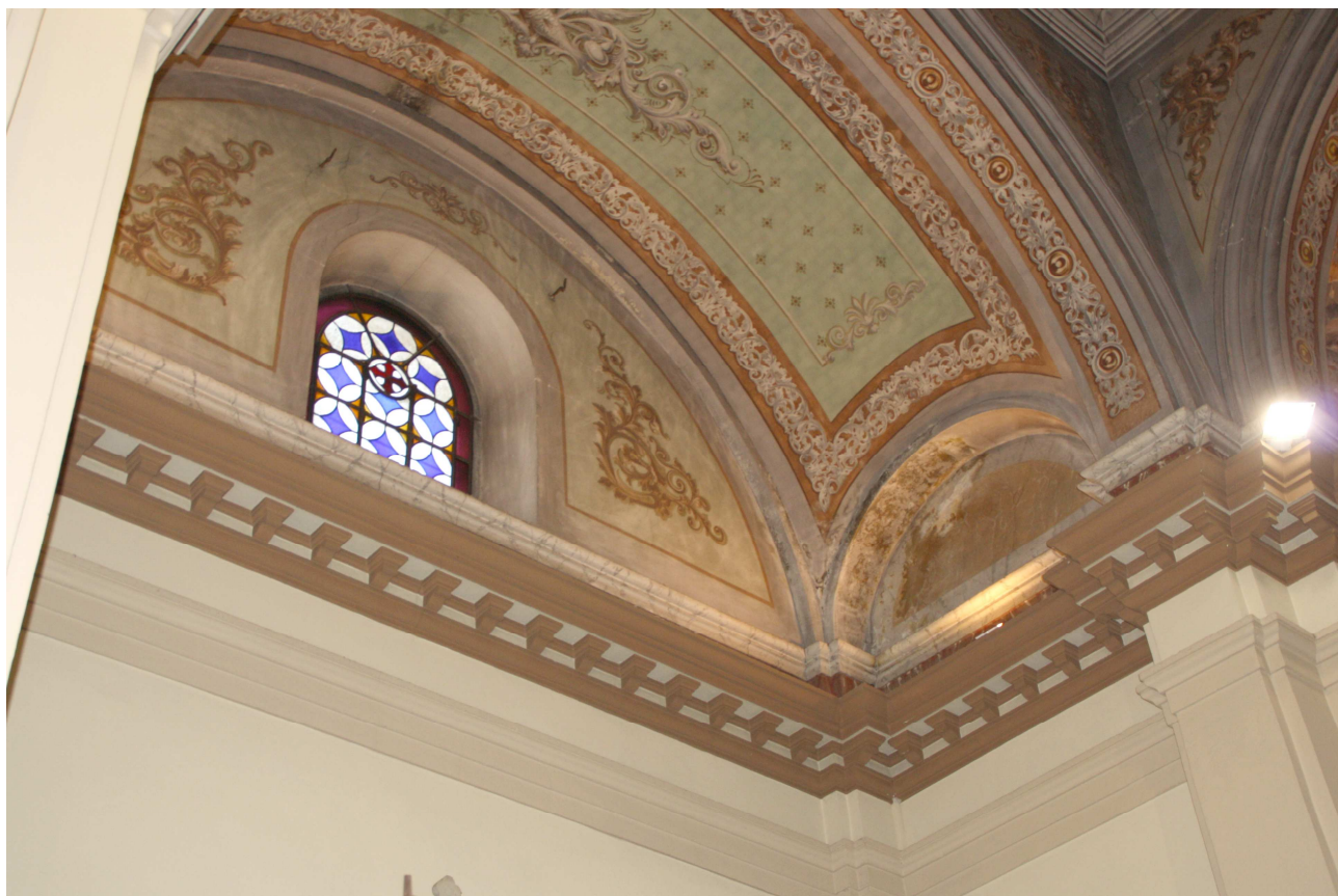
32 – volta sopra altare di sx dell’aula (infiltrazioni dalla volta)
