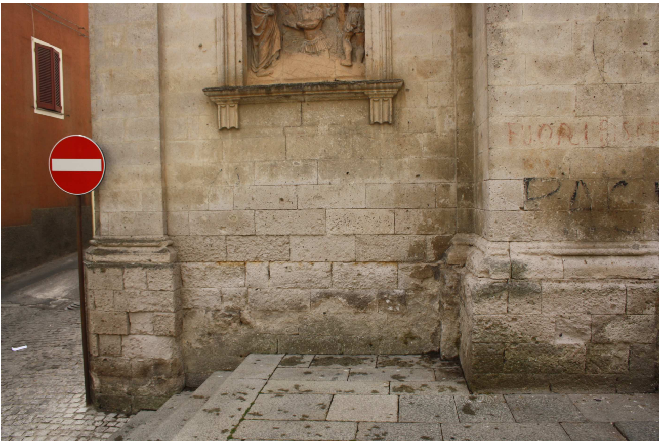
12 - basamento degradato lato sx facciata principale
