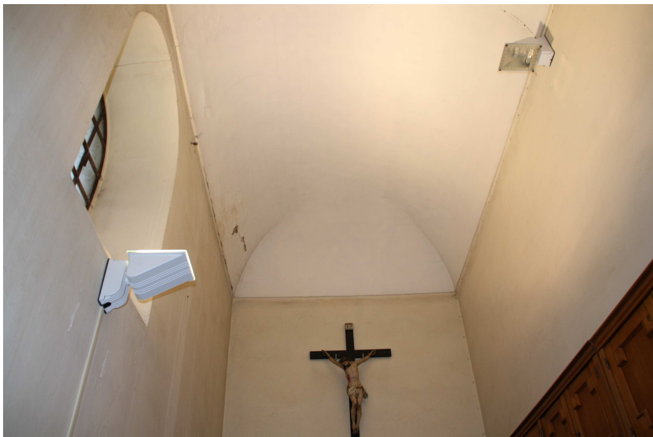
38 – infiltrazioni in volta sagrestia.
