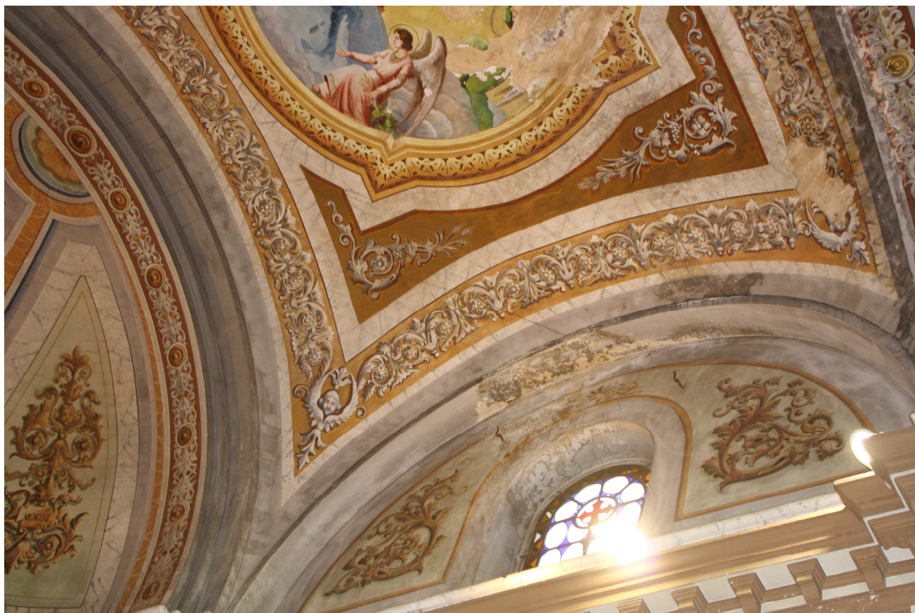
28 – lunetta finestra presbiterio (con intonaci ammalorati) 29 – finestra abside (con infiltrazioni dalla finestra)
