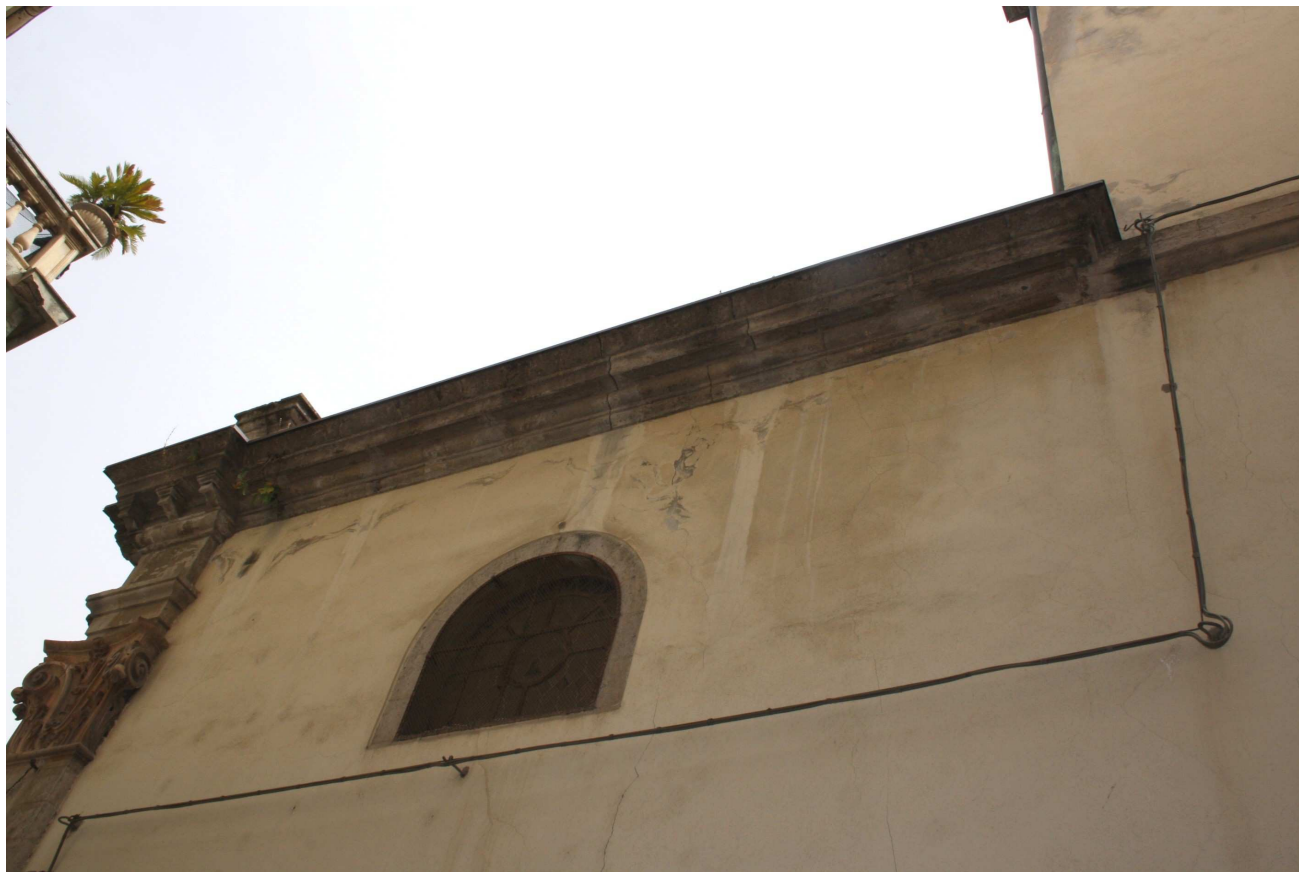
14 - Cornicioni ammalorati facciata laterale destra
