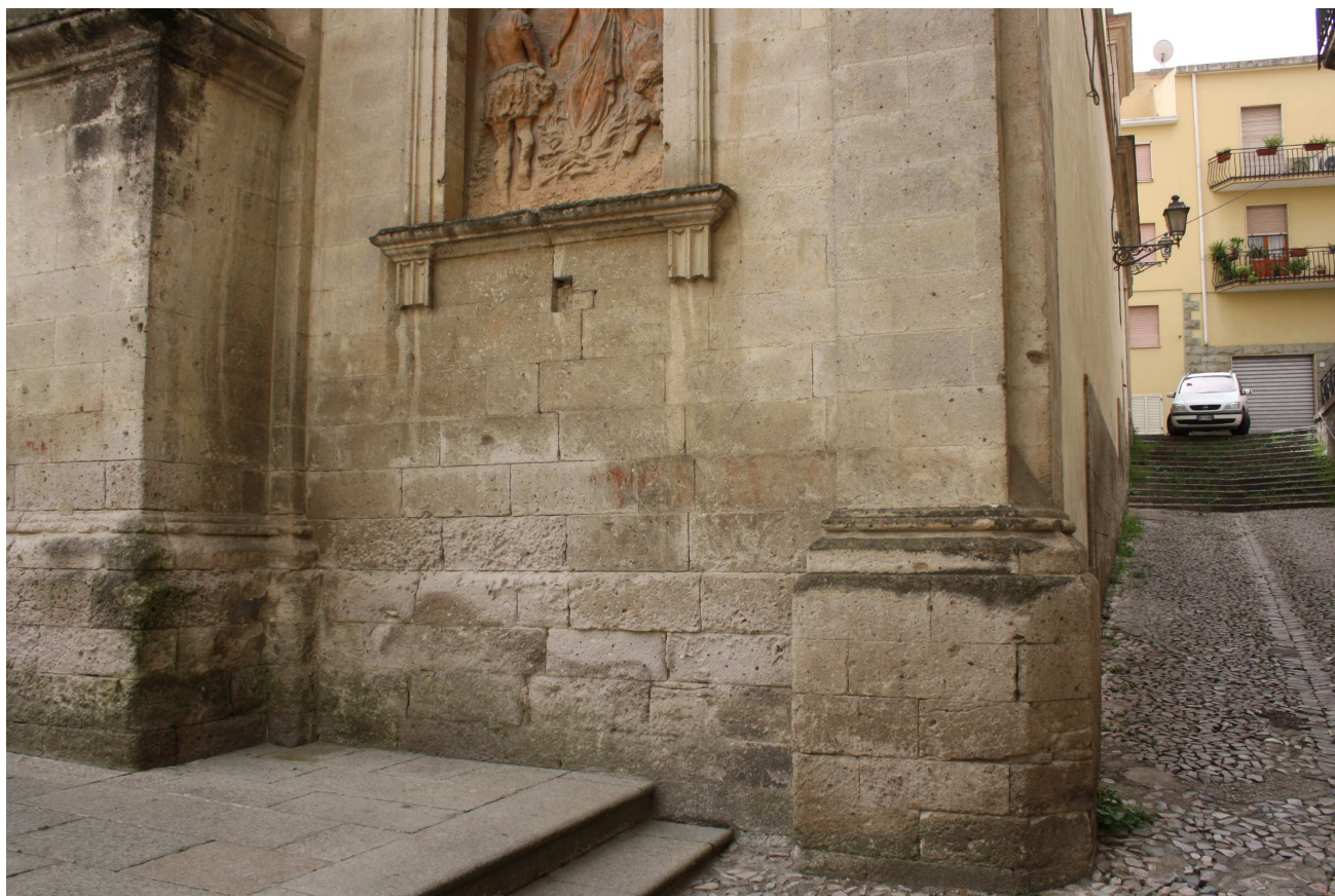
13 - basamento degradato lato dx facciata principale
