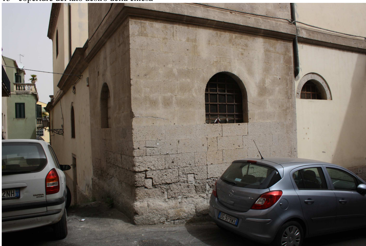
16 - Retrofacciata, basamento ammalorato campanile
