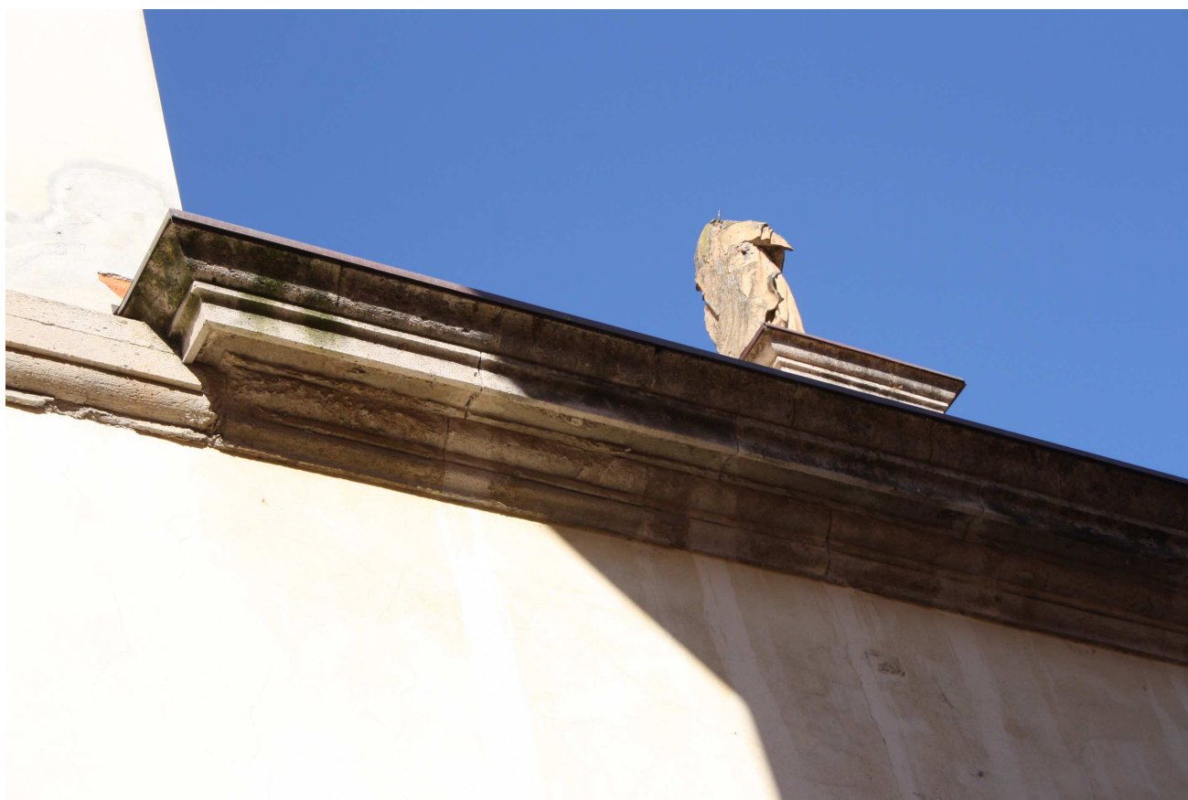
21 - Facciata sinistra, cornicioni ammalorati
