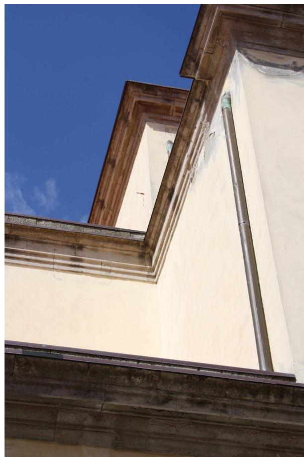
19 - Facciata sinistra, cornicioni ammalorati
