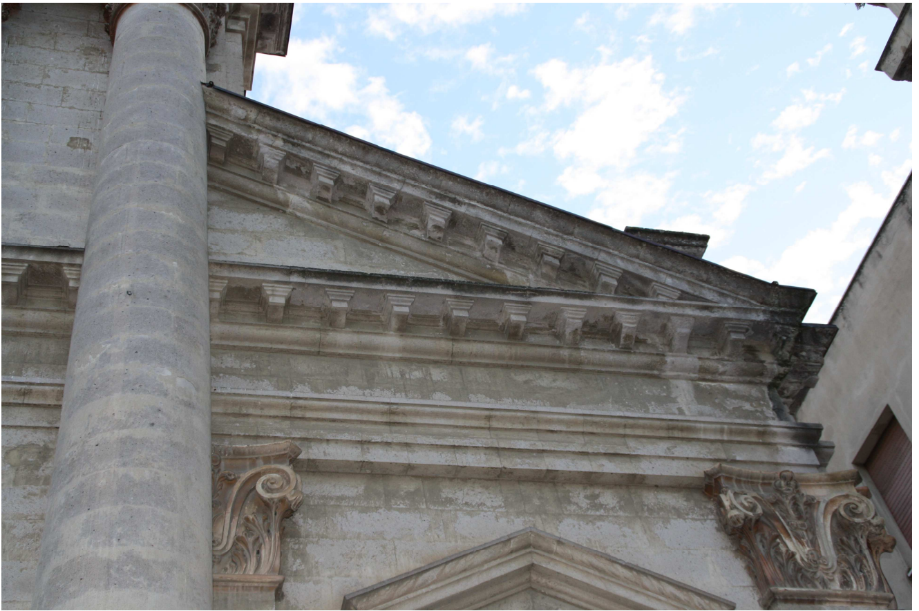
11- timpano navata laterale dx con mensole lesionate
