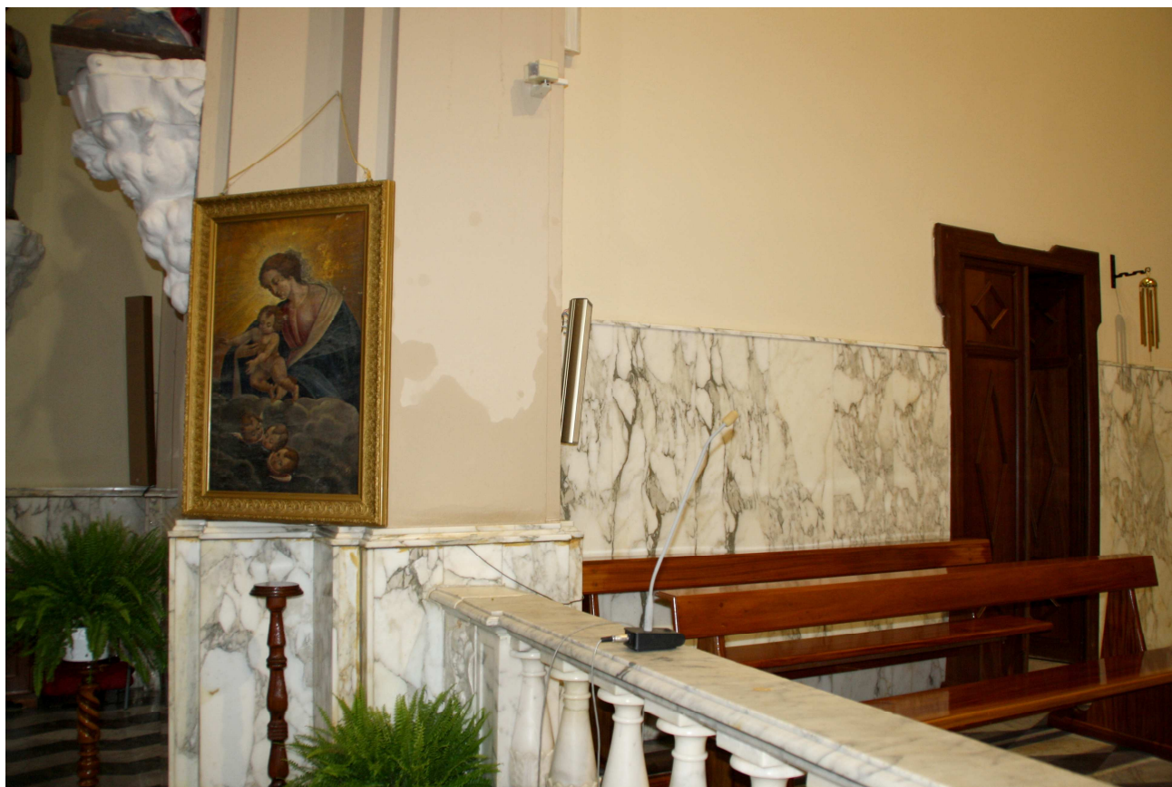
34 – umidità di risalita in parasta arco trionfale.
