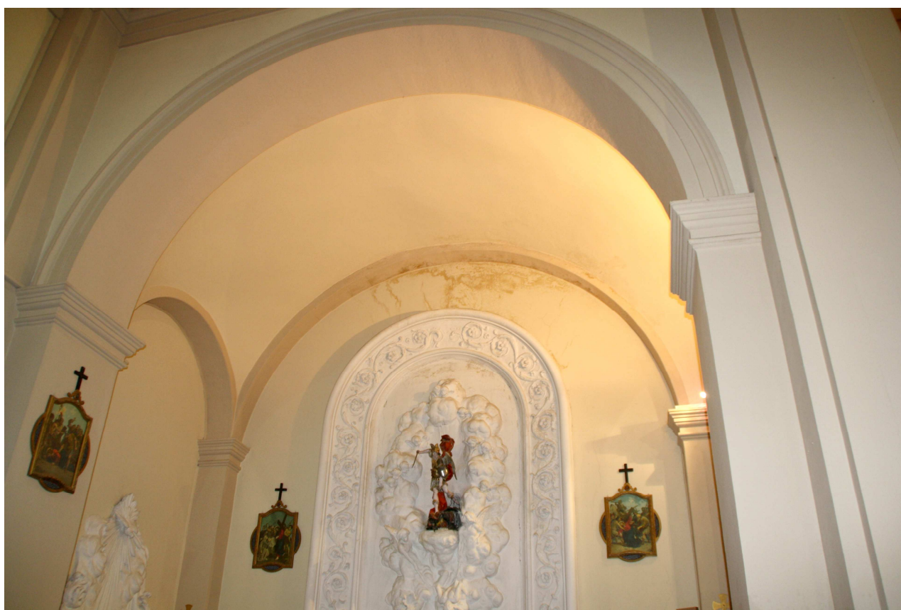
37 – infiltrazioni dal soffitto della cappella di s. Michele.
