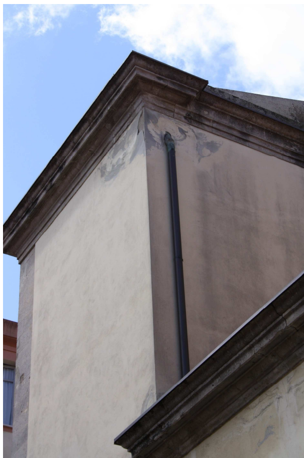
18 - Facciata sx cornicioni ammalorati in prossimità dello spigolo con la retrofacciata
