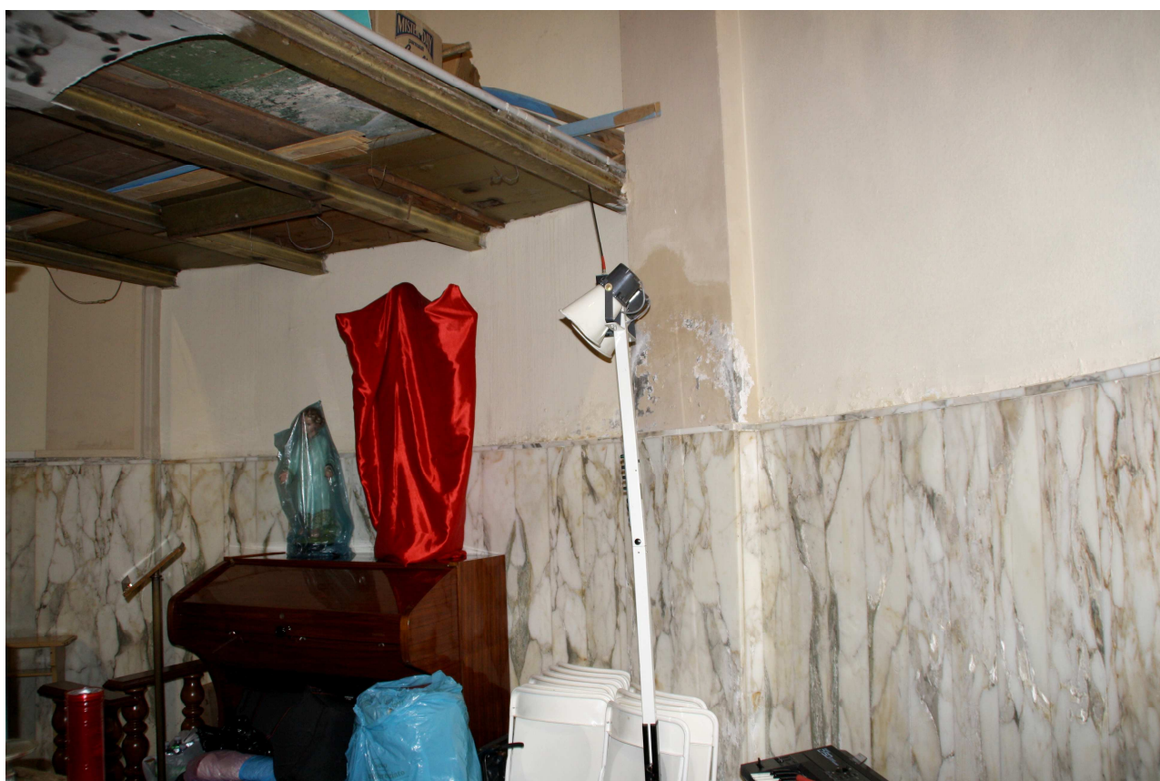
39 – umidità e salnitro nelle murature dell'abside.
