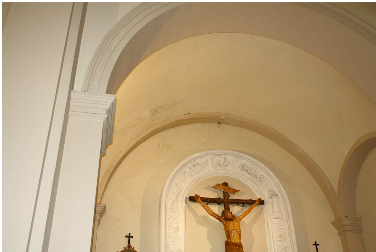
36 – infiltrazioni dal soffitto della cappella di s. Croce.
